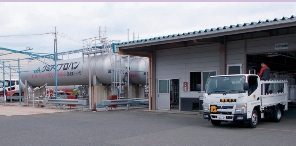
地域の中心的なLPガス充填所の役割担う燃料センター
