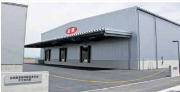
ドックシェルター方式を採用し、青果物の鮮度を保つコールドチェーン化を実現
