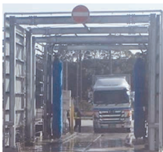
車両消毒をする設備
