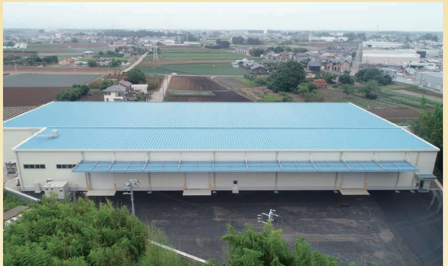
竣工(しゅんこう)した千葉県本部の北総広域連合農業倉庫＝千葉米ターミナル北総(2面)
