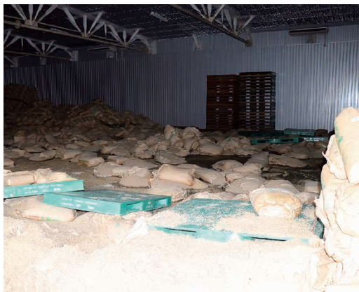
浸水した米倉庫（福島県郡山市の県本部子会社施設）
