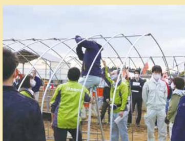
農業用パイプハウスの自力施工で実地研修 (2面)
