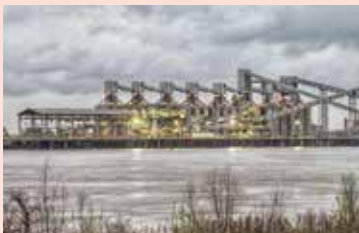
24時間稼働する全農グレイン株式会社の 船積みエレベーター（7面）
