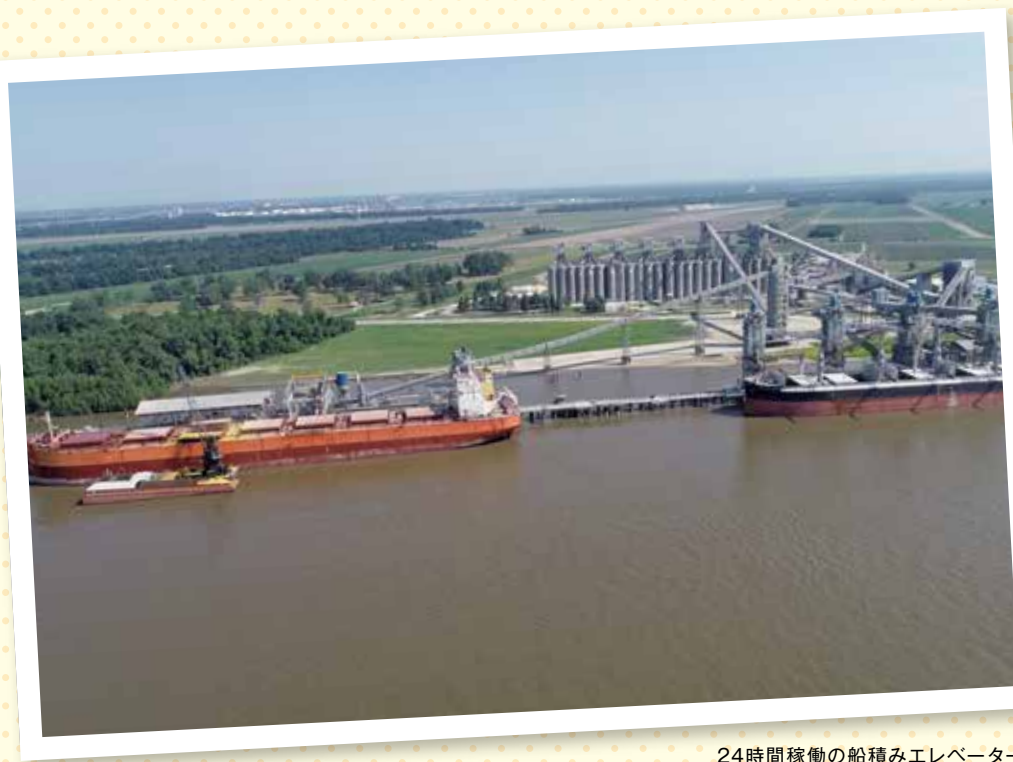
24時間稼働の船積みエレベーター
