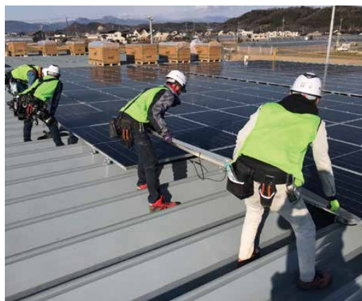
屋根上部に太陽光発電設備を設置
