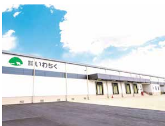
令和2年4月から稼働した 新しい豚処理加工施設
