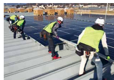
JAファーマーズの屋根上部に太陽光発電設備を設置しPPAモデルを実証
