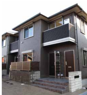
住宅建設の一例
