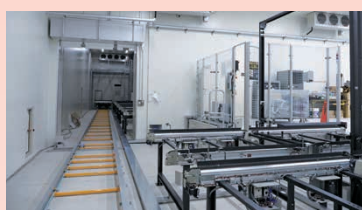
「JA全農京都宇治茶流通センター」竣工(3面)
