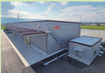
完成した米の低温倉庫「JA全農 めぐみの米 Xross Depo」(2面)
