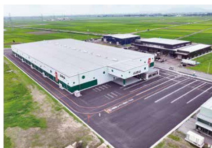
完成した「新潟米広域集出荷施設 田上倉庫」
