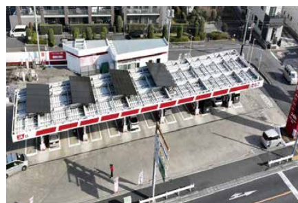
JAに設置した太陽光パネル
