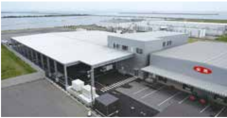
冷蔵施設を拡張した大分青果センター第2次施設
