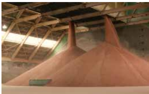
肥料を保管している倉庫内
