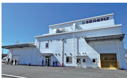
竣工した米粉工場
